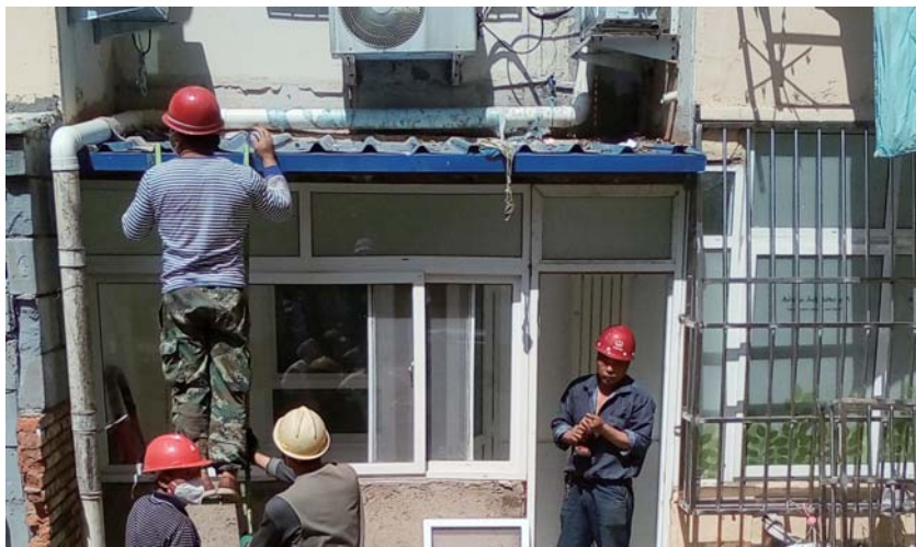
拆除违法建筑。
