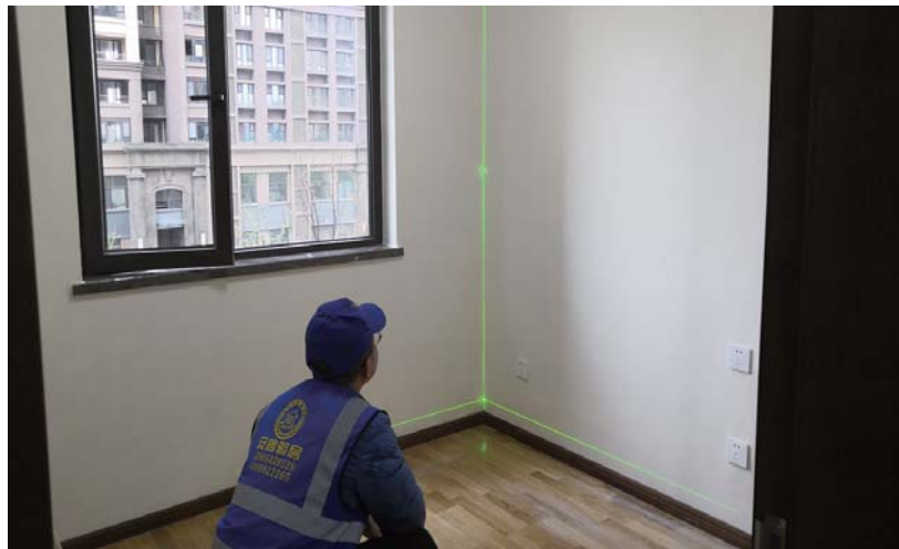
验房师正在检查墙面垂直度。
