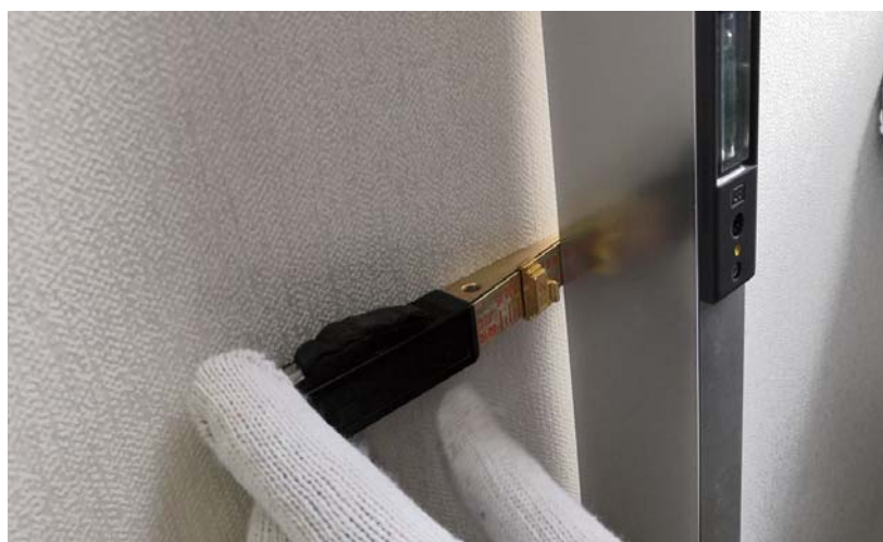
阳台东墙面局部平整度偏差约7毫米,超出相关规范。
