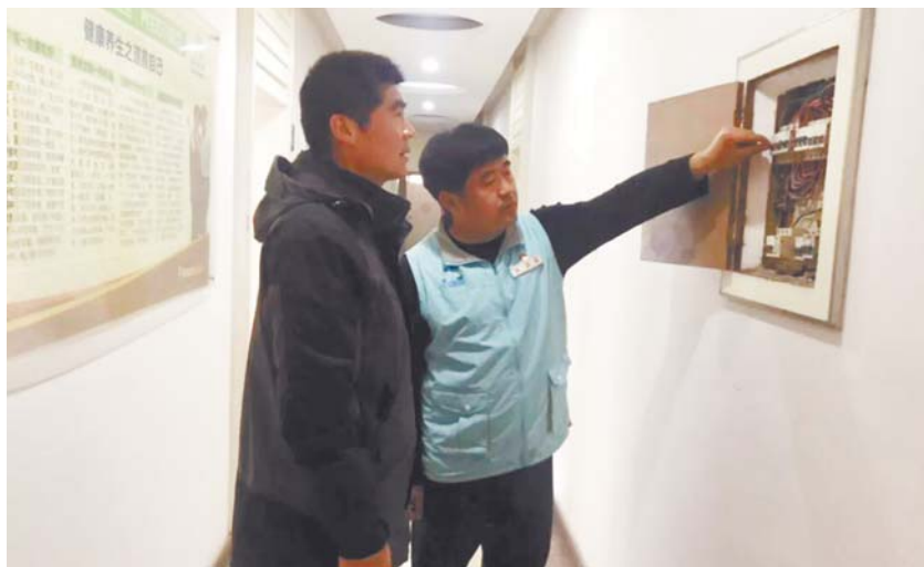
工作人员排查消防隐患。
