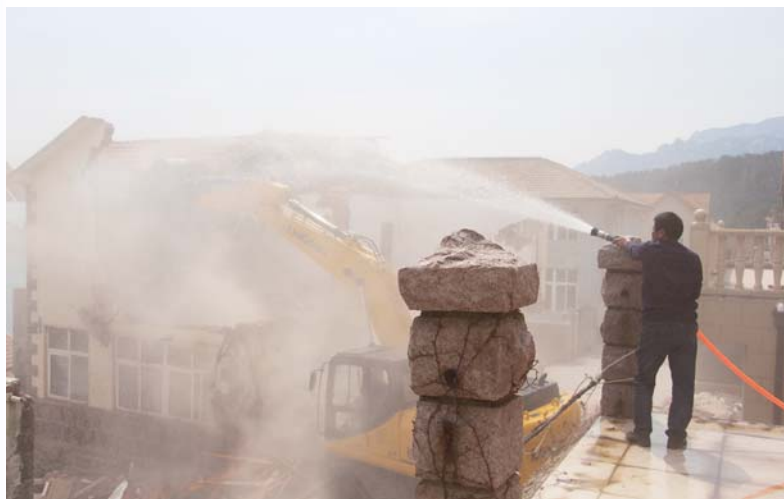
拆除过程中洒水车持续向建筑喷水降低粉尘污染。
