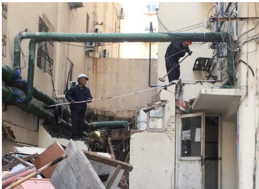
施工人员正在拆除违建。
