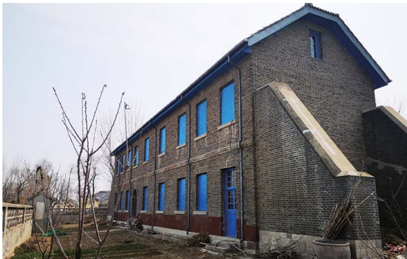
二层青砖楼建筑。
