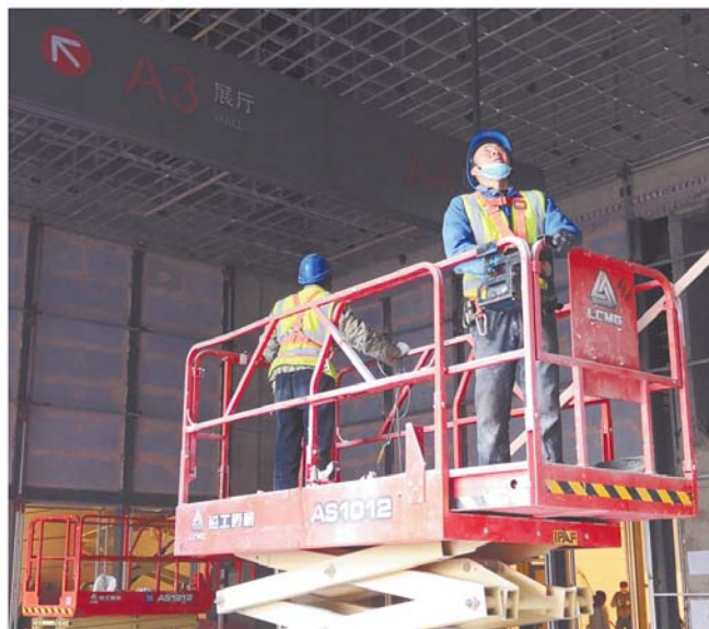
工人们正在加紧施工。
