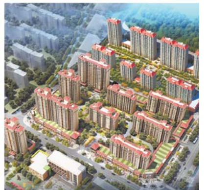
洼里改造项目。
