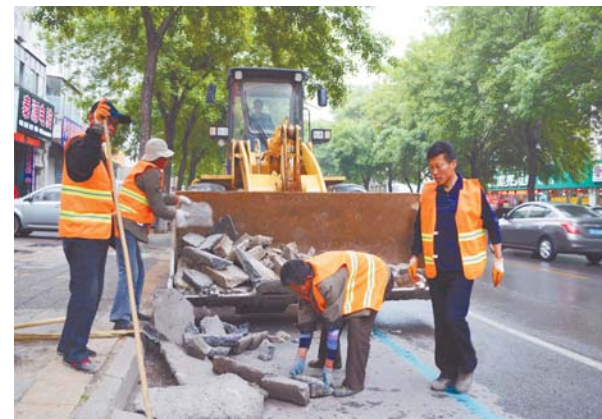
清理路边建筑垃圾。
