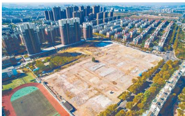
德馨小学扩建工程。
