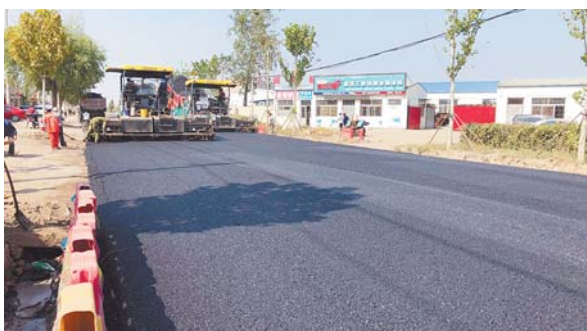
即兰路大中修工程施工。
