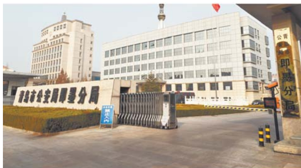
即墨公安分局办公大楼。
