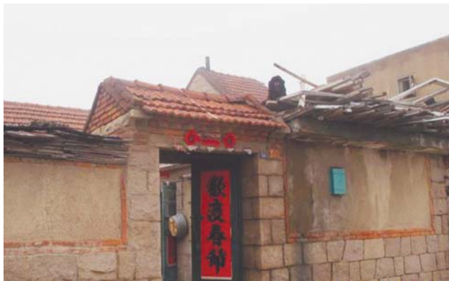
钟家沟社区改造前的低矮房屋。(资料图片)
