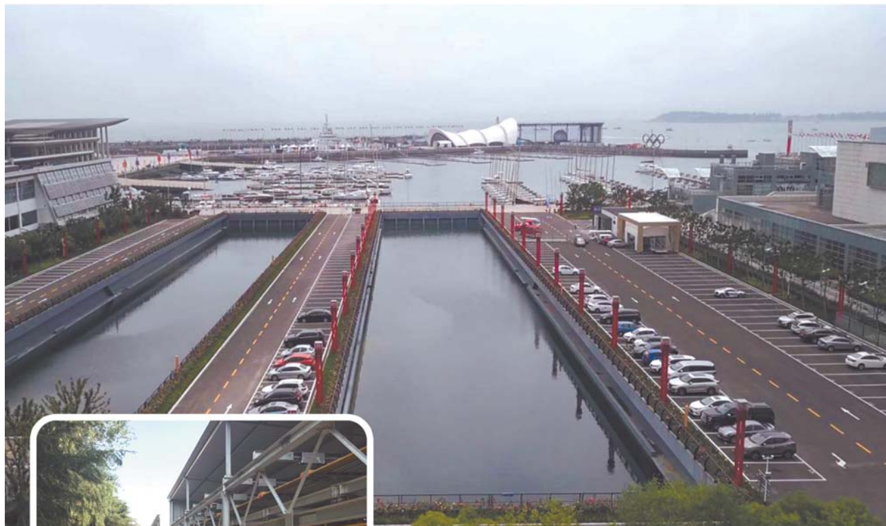
▲改造后的旅游集团奥帆中心干船坞停车场。
