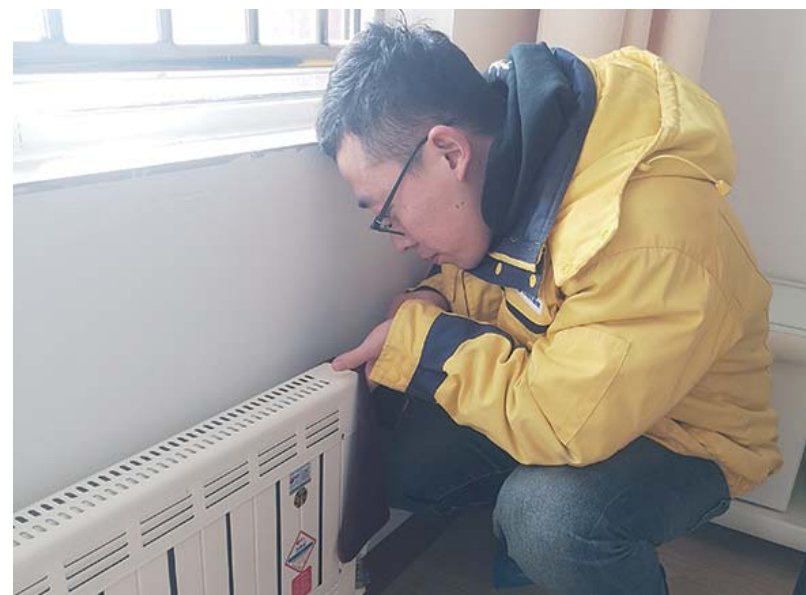
用户家中维修进行中
