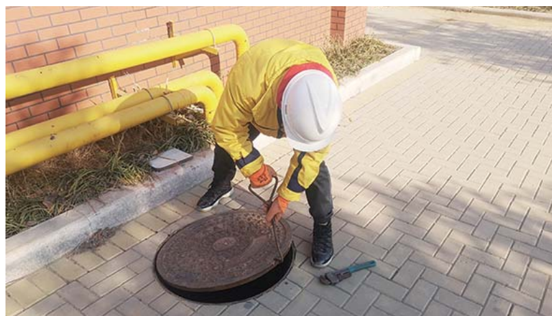
例行室外管道检查
