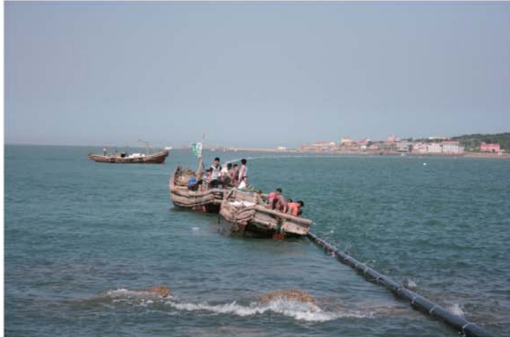
2010年，即墨自来水公司铺设海底管道3510米。
