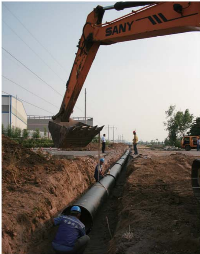
2017年6月，施工人员正在加紧推进汽车产业新城供水配套工程。
