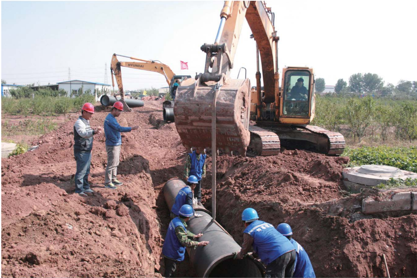
2015年，即墨自来水公司实施了海润丰水厂向城区引水工程。
