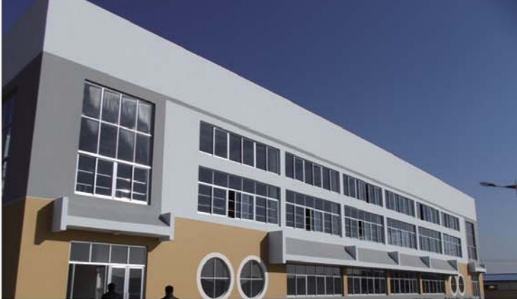
2013年扩建的同济水厂三期工程，为城区日增供水3万立方米。
