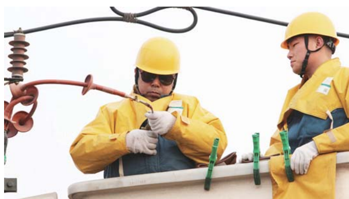
为保证供电，他们不惧严寒在高空坚持作业。
