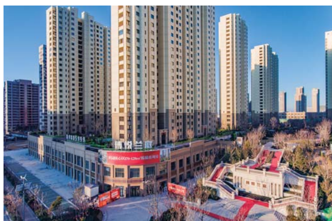
博悦兰庭保障房项目。
