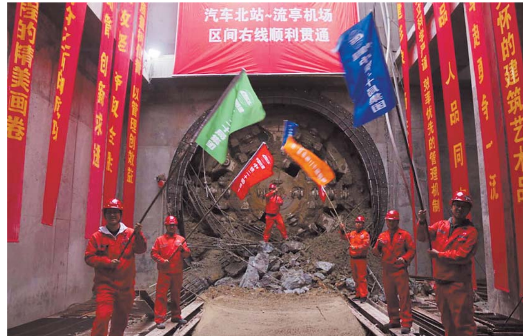
地铁1号线最长盾构区间双线贯通现场。(青岛地铁集团供图)
