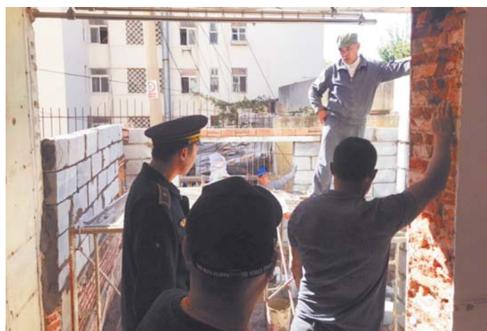
执法人员要求施工人员立即停工。
