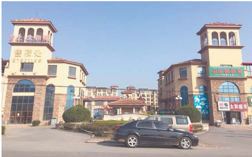
小区交房6年多，迟迟未供暖。
