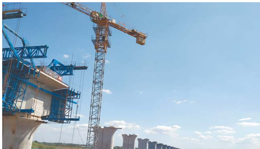
潍莱高铁徐家会村施工现场。
