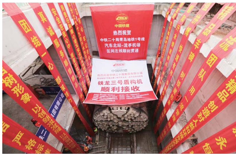
汽流区间左线顺利贯通。(青岛地铁集团供图)
