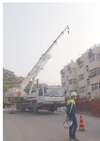
金岭新村一期房屋修缮现场。
