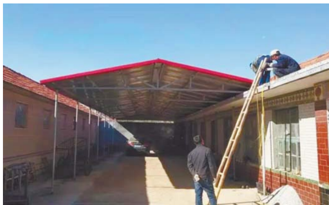
吴家口村的违建彩钢大棚被拆除。
