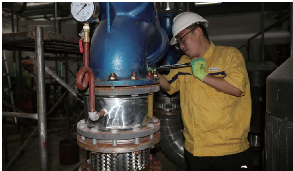
工作人员拆洗过滤器
