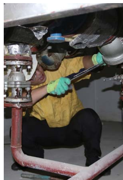
工作人员检修过滤器以及热力小室所有管件
