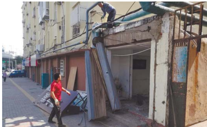
云南路街道拆除违建群租房。
