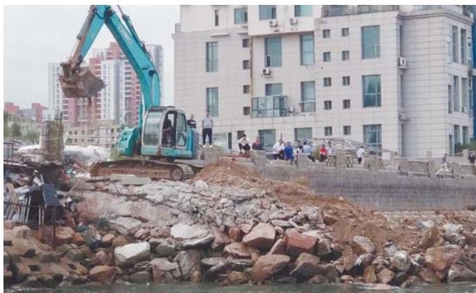
云南路街道拆除码头和简易房。
