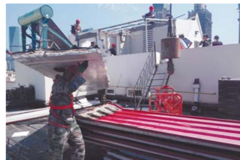
湛山社区太平角六路11号违建被拆除。
