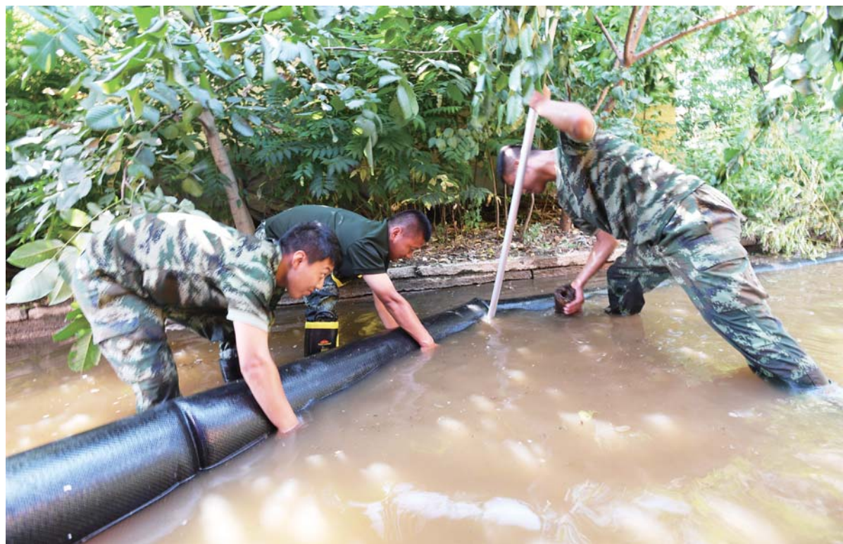
消防官兵正奋力排除积水。
