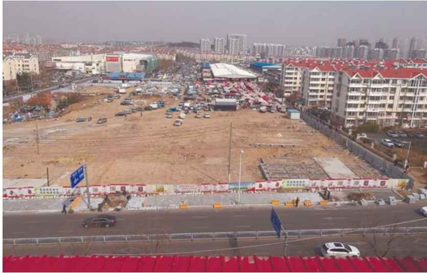
烧烤街拆迁后，空地正在平整建设停车场。
