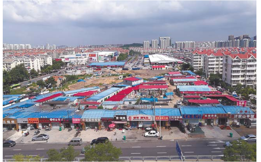
烧烤街拆迁前，违建占据整块空地。
