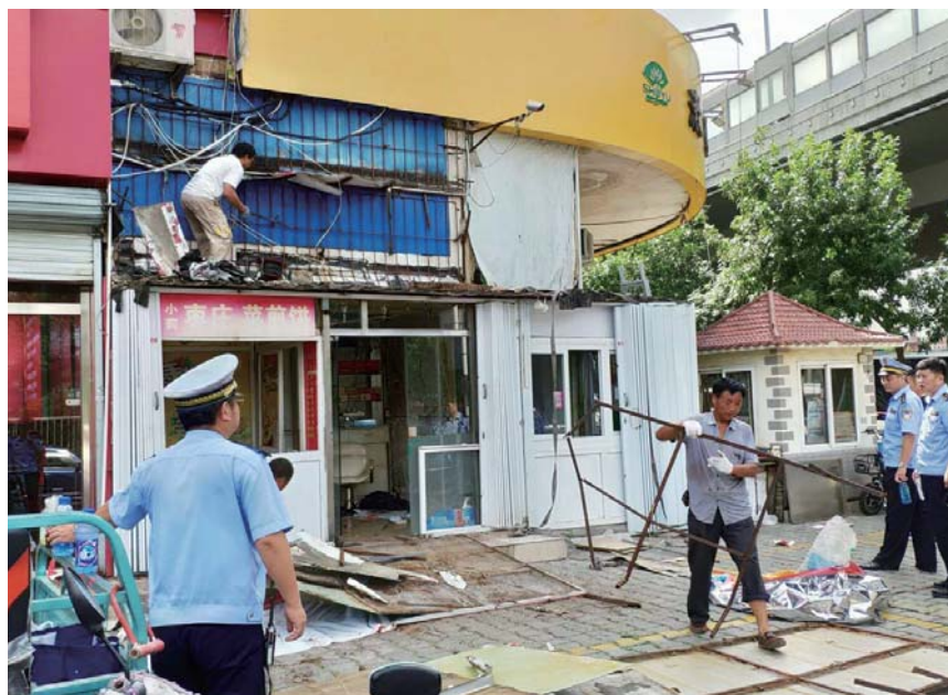
拆除宁夏路164号违建现场。
