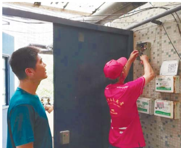
澳门路社区维修存在安全隐患的防盗门。
