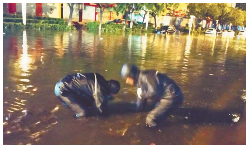
工作人员冒雨打开排水不畅的雨水算子和古力井盖。
