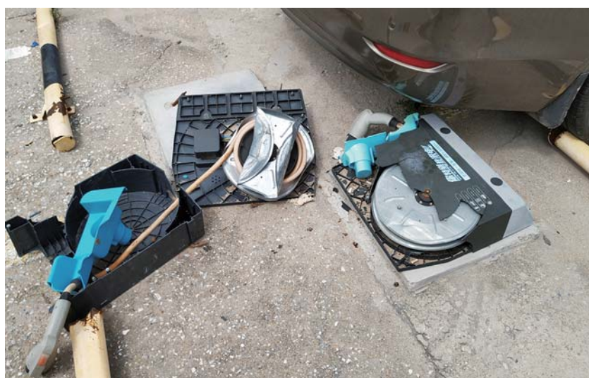
充电桩已经损坏。
