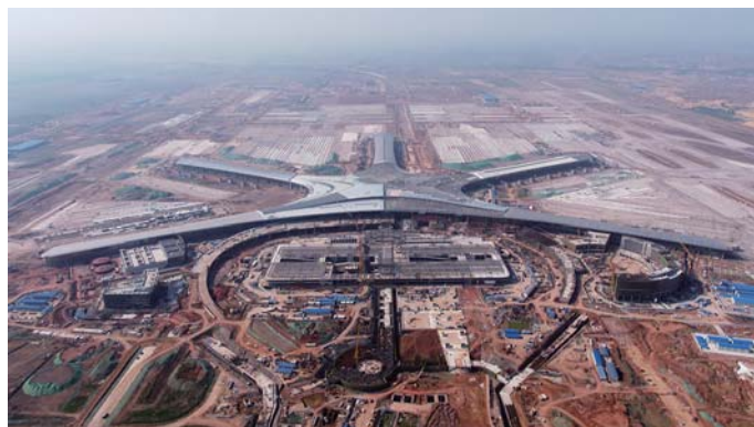
4F级胶东国际机场正在建设。
