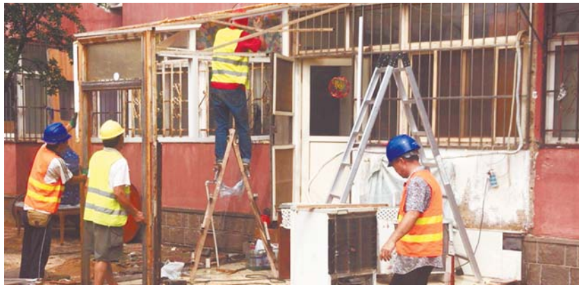
违建拆除现场。
