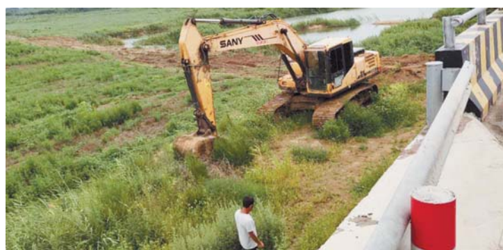
大沽河上游整治施工。
