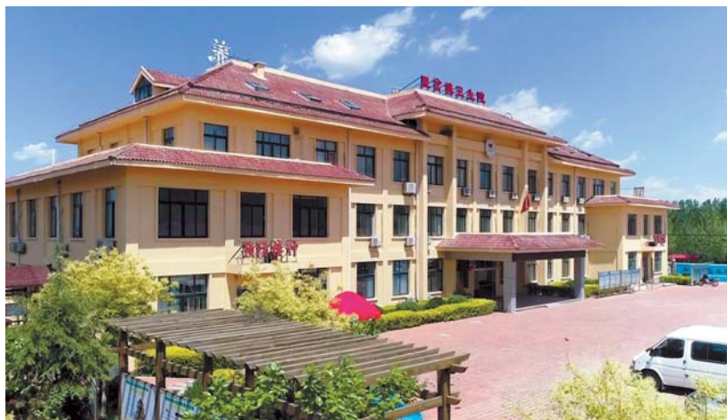
新建里岔卫生院120急救中心。
