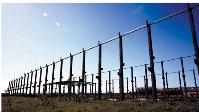
项目建设现场。
