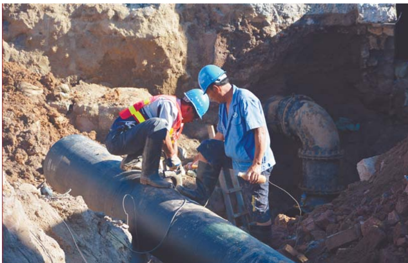
烈日当头,施工人员在切割管道。
