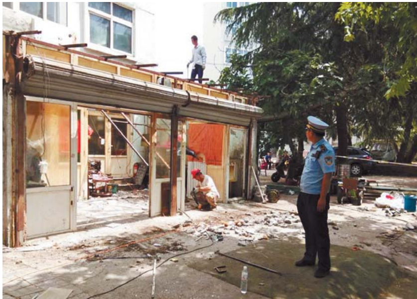
拆除太湖路多年老违建。
