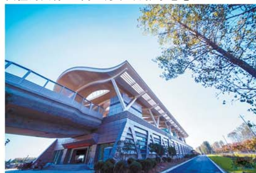
地铁11号线泉虞站。
