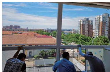
开发商安排施工队重新安装窗户。
