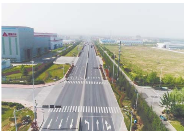
中铁十四局市政公司承建的昆仑山路北段拓宽改造工程。
