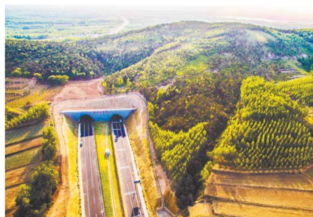
中铁十四局市政公司承建的青岛西海岸新区开城路二期工程。
