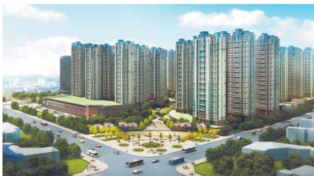
青建承建的九龙社区项目。
