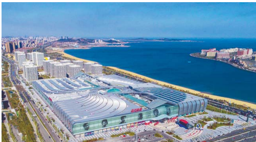
中建八局第一建设有限公司承建的东方影都万达茂项目。摄影 李伟
