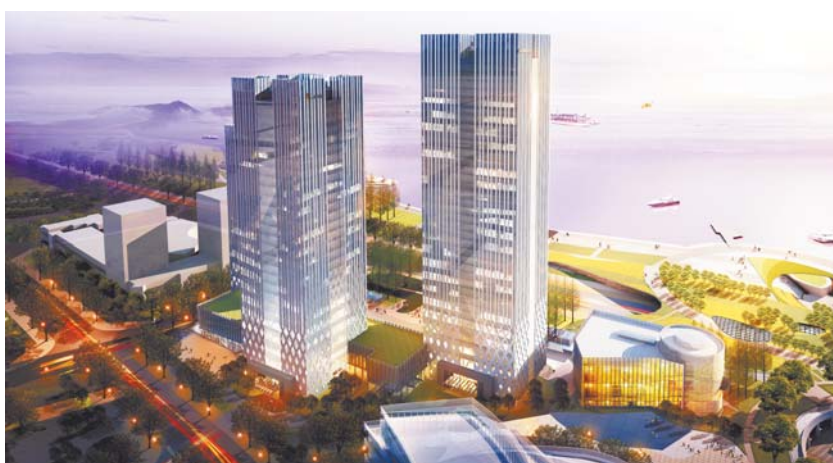
中建八局第一建设有限公司承建的山东(青岛)国际航运中心(A1地块)项目。
