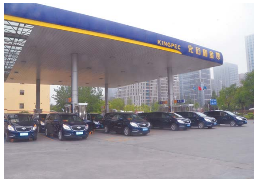
金盾加油站保障上合青岛峰会车辆加油。
