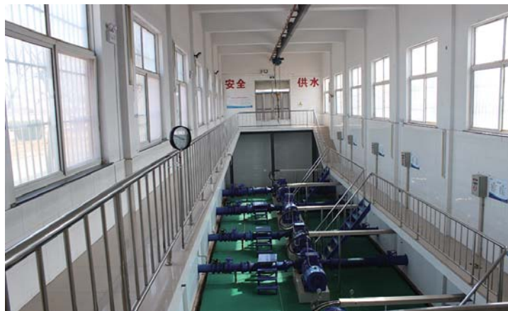
前韩水厂深度处理工程月底即将开工。
