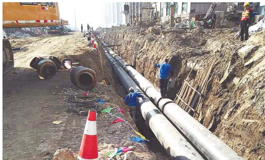
保障蓝堡湾供热的常州路高温水工程正在抓紧施工。
