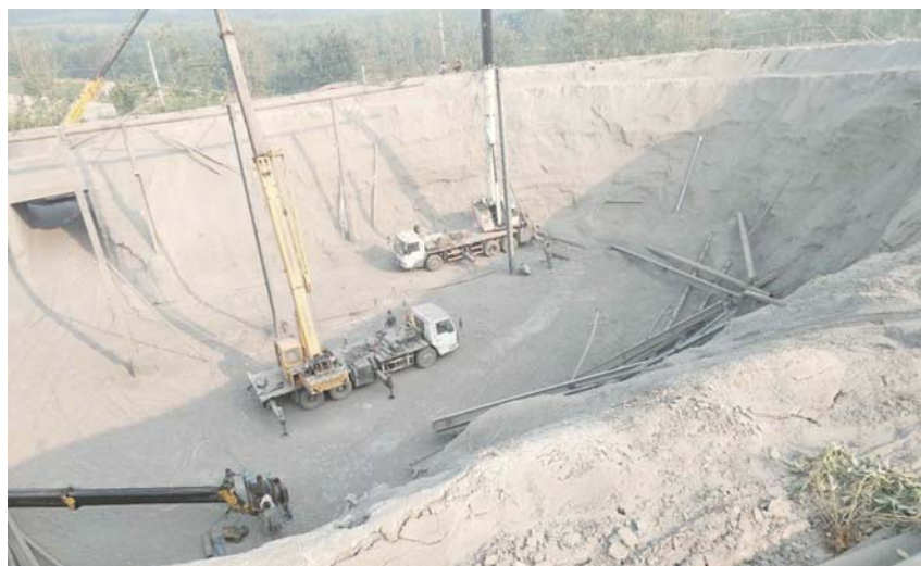
5000余平方米违建深坑被拆除。
