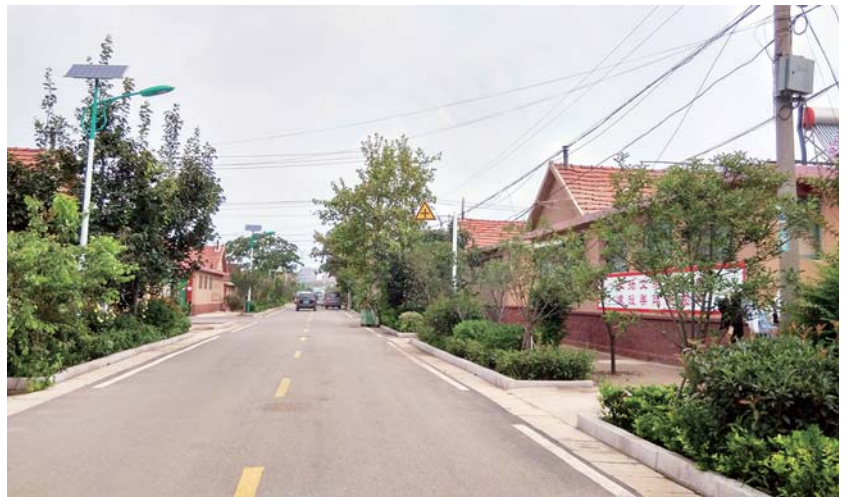
村内道路宽敞明亮、安装太阳能路灯,两侧绿树红花掩映房屋。
