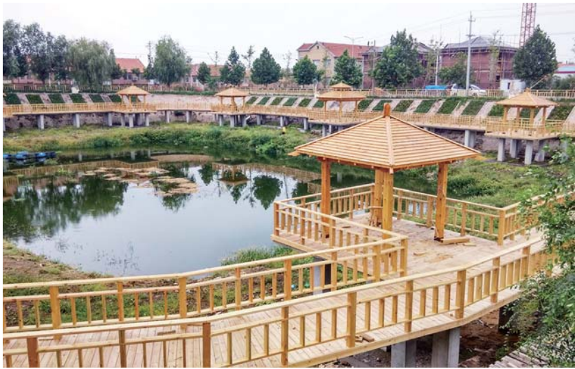
“古墨风堂”正在建设中。
